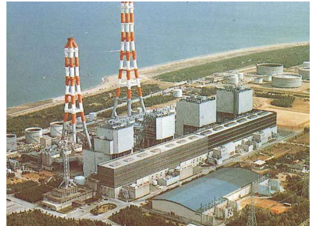
東京電力柏崎刈羽原子力発電所 (1986年)
