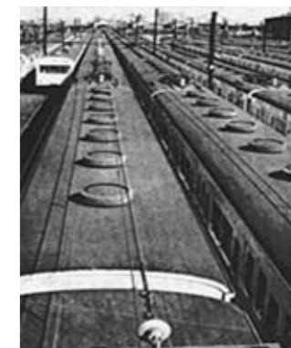
塩化ビニル樹脂シートによる国鉄車両屋根材として採用（1952年）（出典先：全防協発行「日本の防水100年」）
