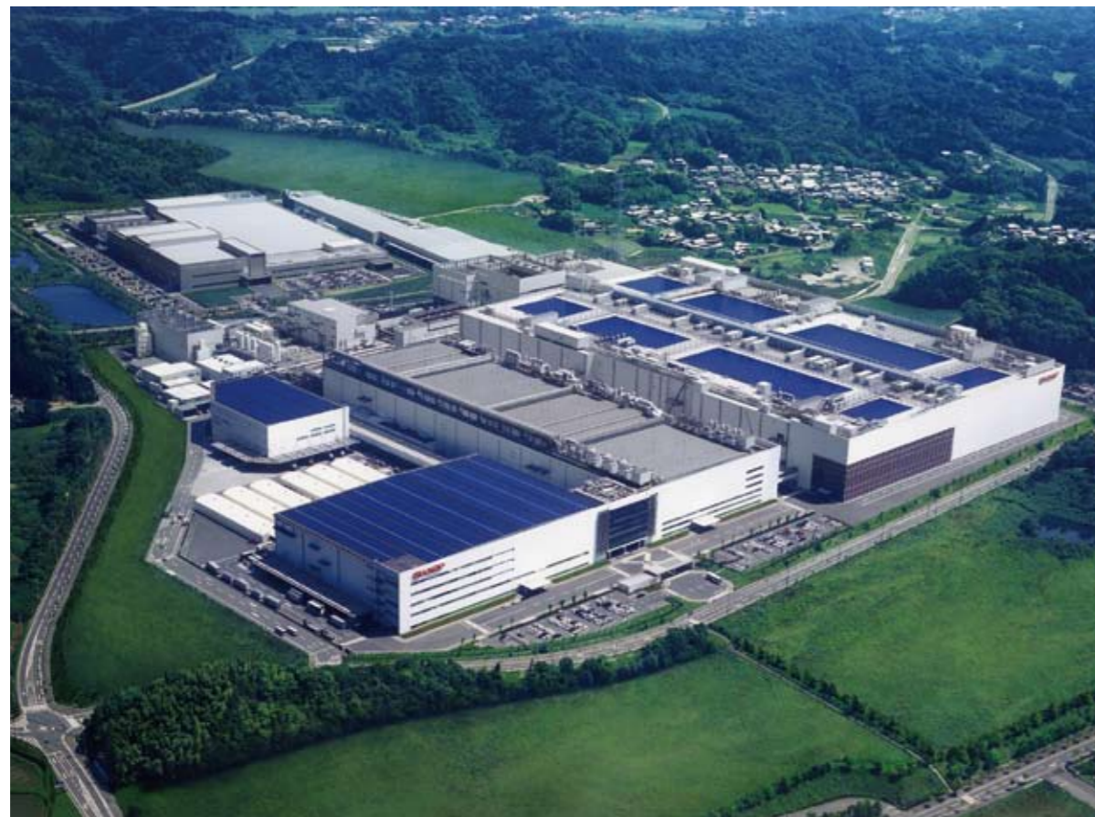
シャープ亀山工場 (2004年)
