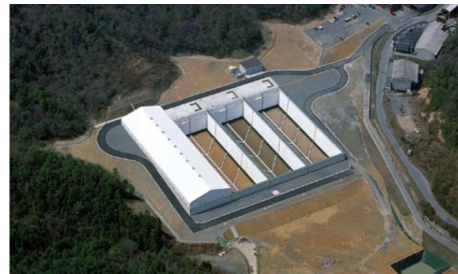
改質アスファルト系シートによる閉鎖型処分場処分場遮水工事に採用 (2007 年)
