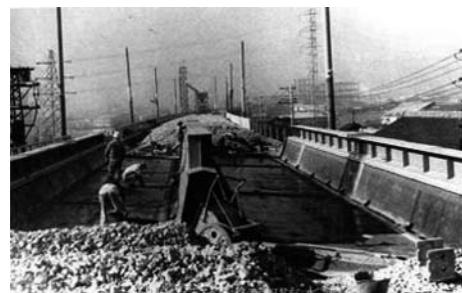
東海道新幹線橋梁防水（1964年）
