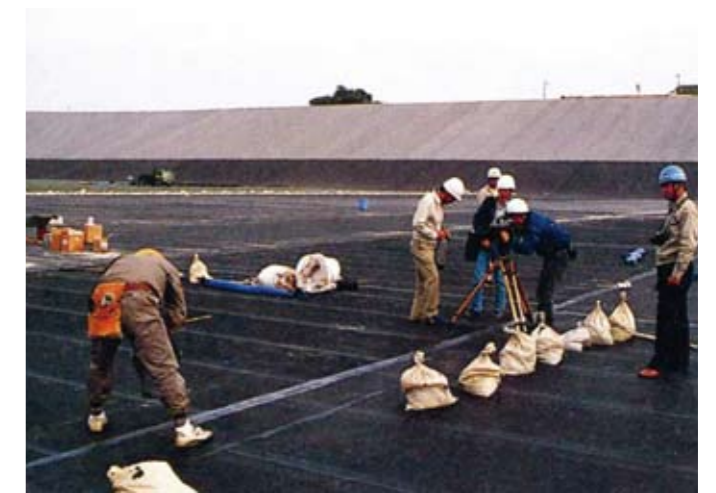
東海農政局万場調整池の施工現場 (1989年)
