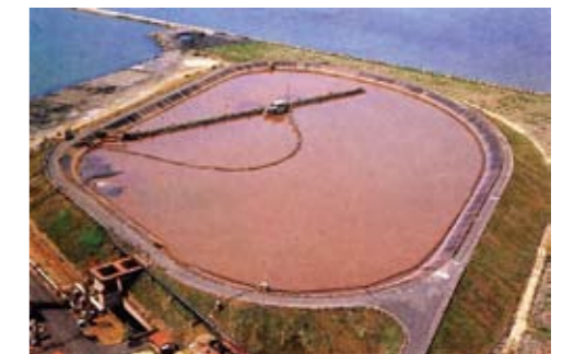
新日鐵広畑スラリーポンド (1972年)
