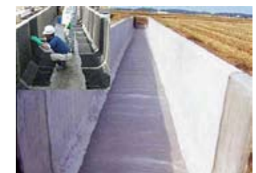
農業用水路改修用 EVA 系シートに採用 (2008 年)
