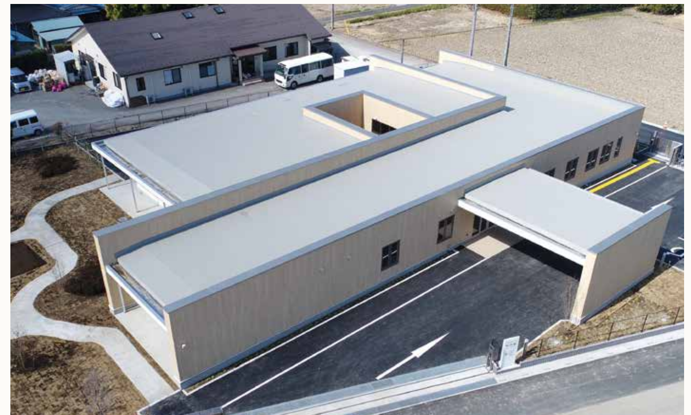
福祉サービス事業所 明日葉 塩化ビニル樹脂系シート防水機械的固定断熱工法
