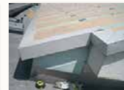
軒先部固定金具の設置
