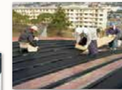
加硫ゴム系シートの敷設
