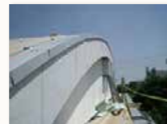
ケラバ部固定金具の設置
