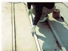
バッカー材張付け
