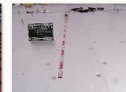
断熱材の固定
