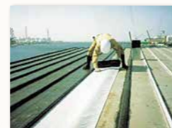
非加硫ブチルゴム系シートの敷設
