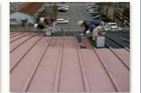
仕上げ塗料塗布
