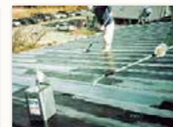
仕上げ塗料塗布
