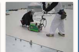
熱可塑性エラストマー系 シートの敷設
