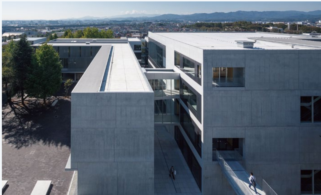
工学院大学125周年記念総合教育棟 加硫ゴム系シート防水高断熱接着工法
