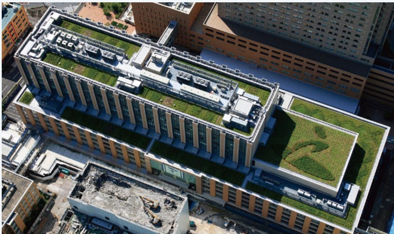
帝京大学板橋キャンパス大学棟 塩化ビニル樹脂系シート機械的固定断熱工法・屋上緑化
