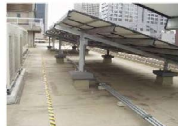
1 コンクリート基礎による設置例
