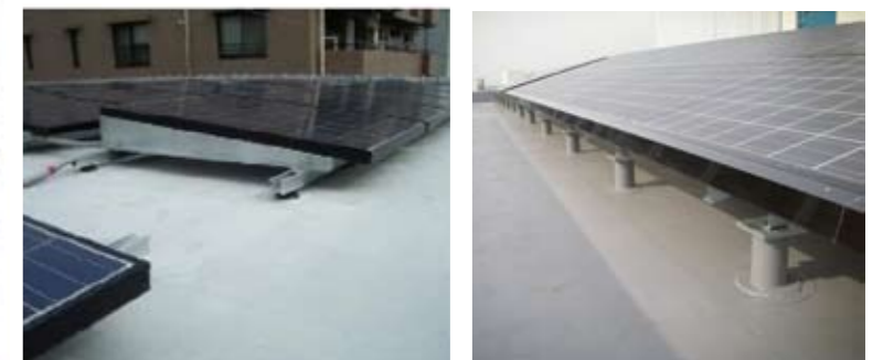
2 シート防水専用治具による設置例
