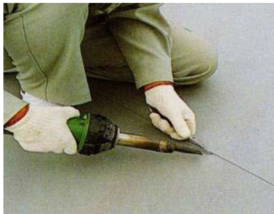
熱風溶接機による熱融着
