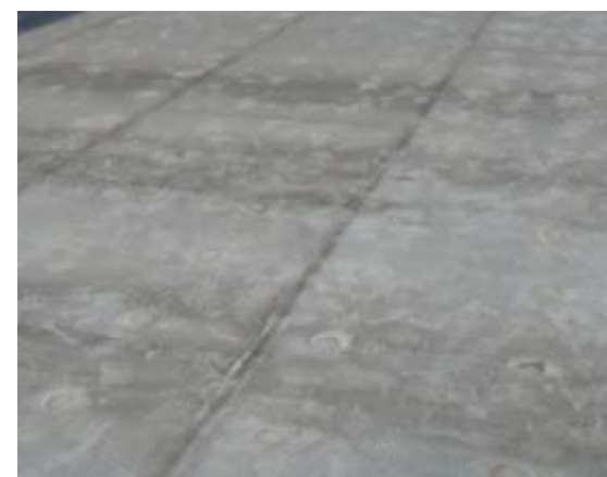
劣化度Ⅰ 損傷無し
