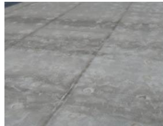
劣化度Ⅰ 損傷無し
