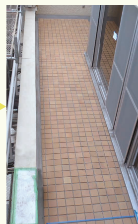
保護モルタル 10mm程度 + 新設タイル
