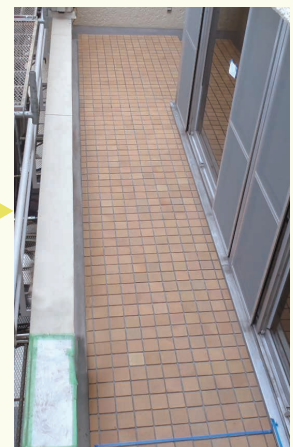
保護モルタル 10mm程度 +新設タイル
