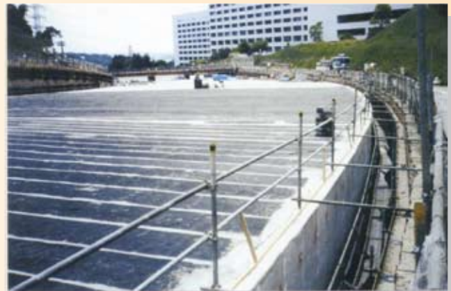
多摩丘陵モノレールトンネル部
