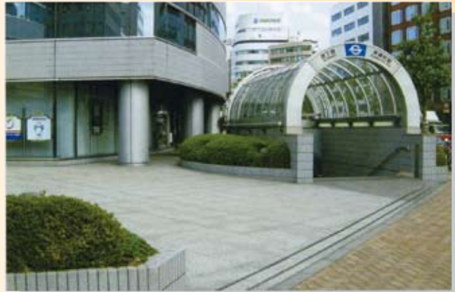
茅場町駅周辺人工地盤
