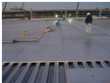
金属下地での断熱材敷設例
