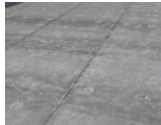
劣化度Ⅰ 損傷無し
