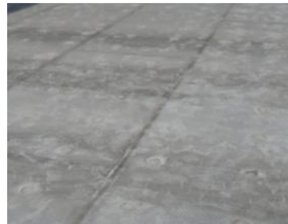
劣化度Ⅰ 損傷無し
