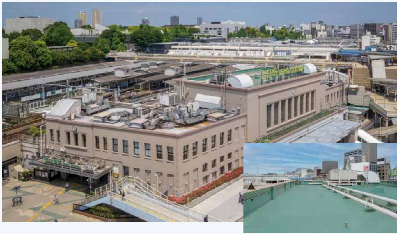
JR 上野駅 塩化ビニル樹脂系シート防水機械的固定工法（コンクリート下地）
