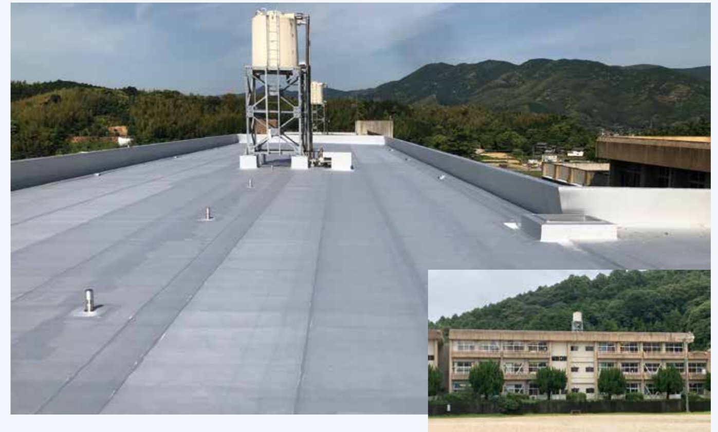
三田市立すすかけ台小学校 塩化ビニル樹脂系シート防水機械的固定工法（コンクリート下地）
