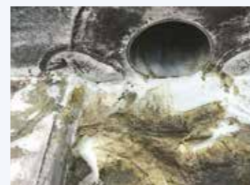
写真-1. 排水口付近
