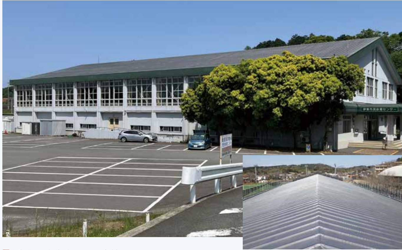
山梨県立富士河口湖高校 加硫ゴム系シート防水接着工法（金属下地）
