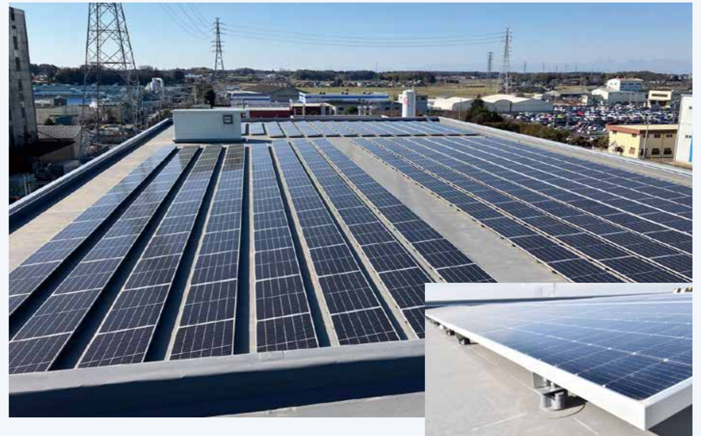
月島食品 塩化ビニル樹脂系シート防水機械的固定工法（コンクリート下地）
