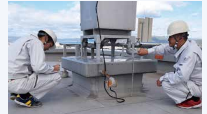
露出防水層の点検
