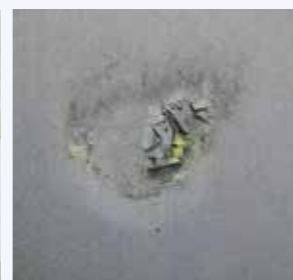
写真-4. 固定金具付近
