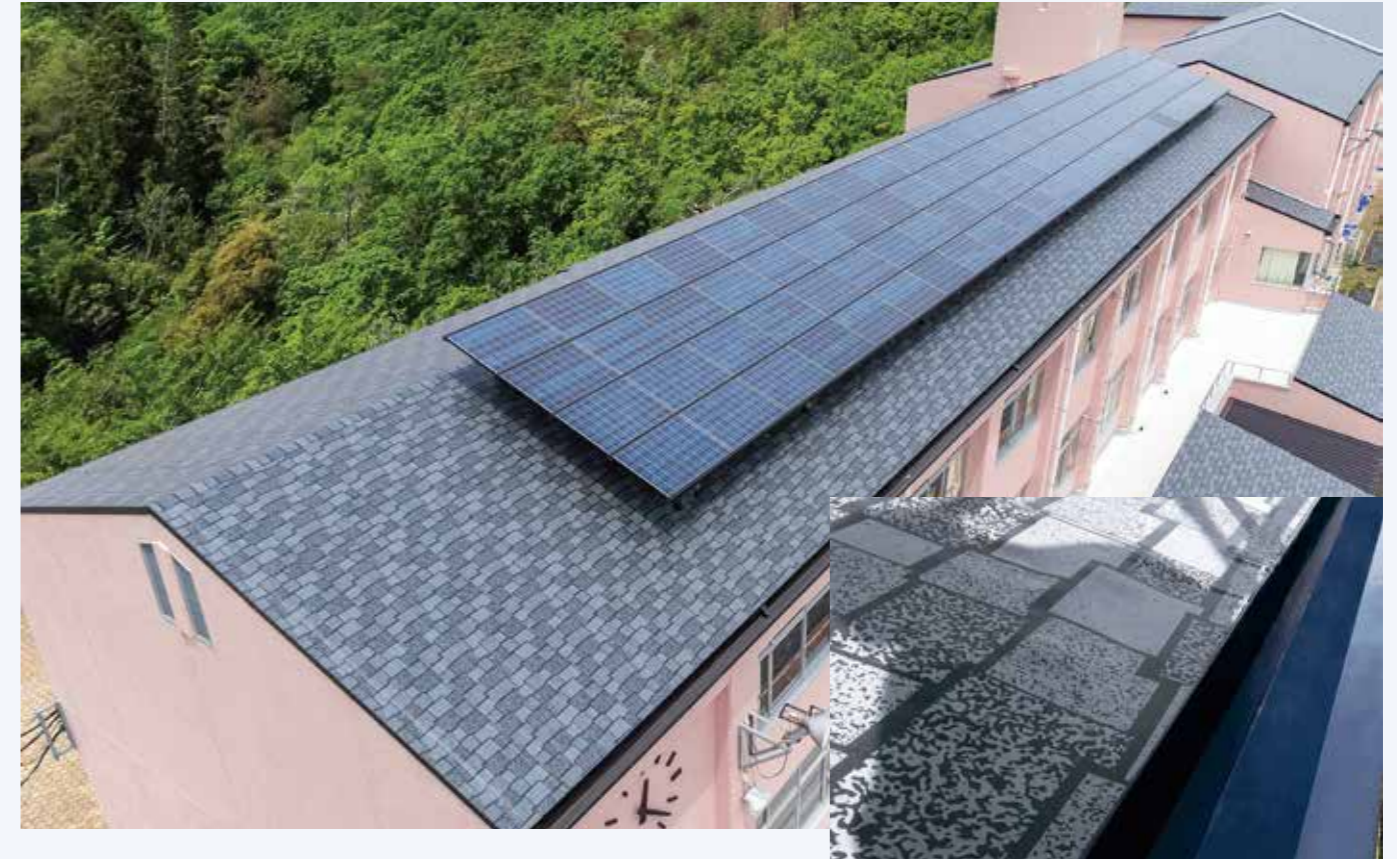
三田市立すすかけ台小学校 塩化ビニル樹脂系シート防水機械的固定工法（コンクリート下地）
