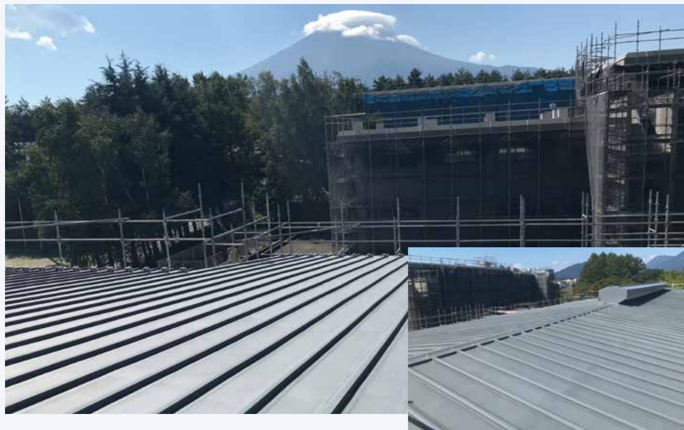
山梨県立富士河口湖高校 加硫ゴム系シート防水接着工法（金属下地）
