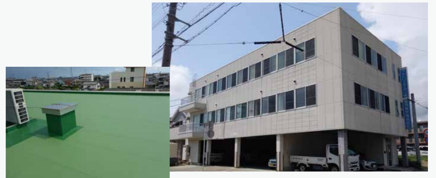
協同建材株式会社 加硫ゴム系シート防水通気緩衝接着工法（ALC下地）
