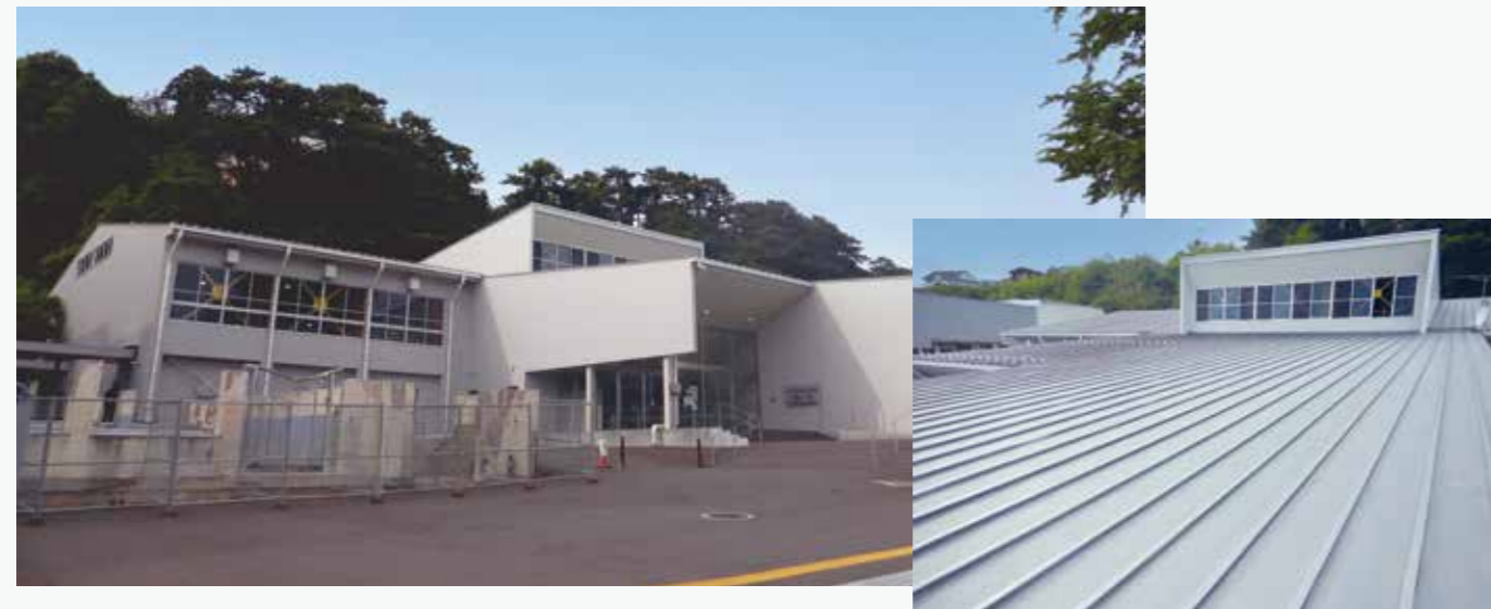
石巻市震災遺構 門脇小学校 加硫ゴム系シート防水接着工法（金属下地）
