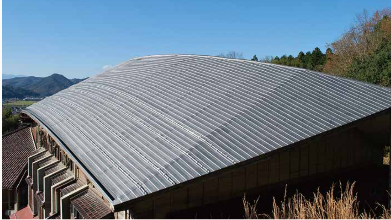
清水建設ものづくり研修センター 塩化ビニル樹脂系シート防水機械的固定断熱工法
