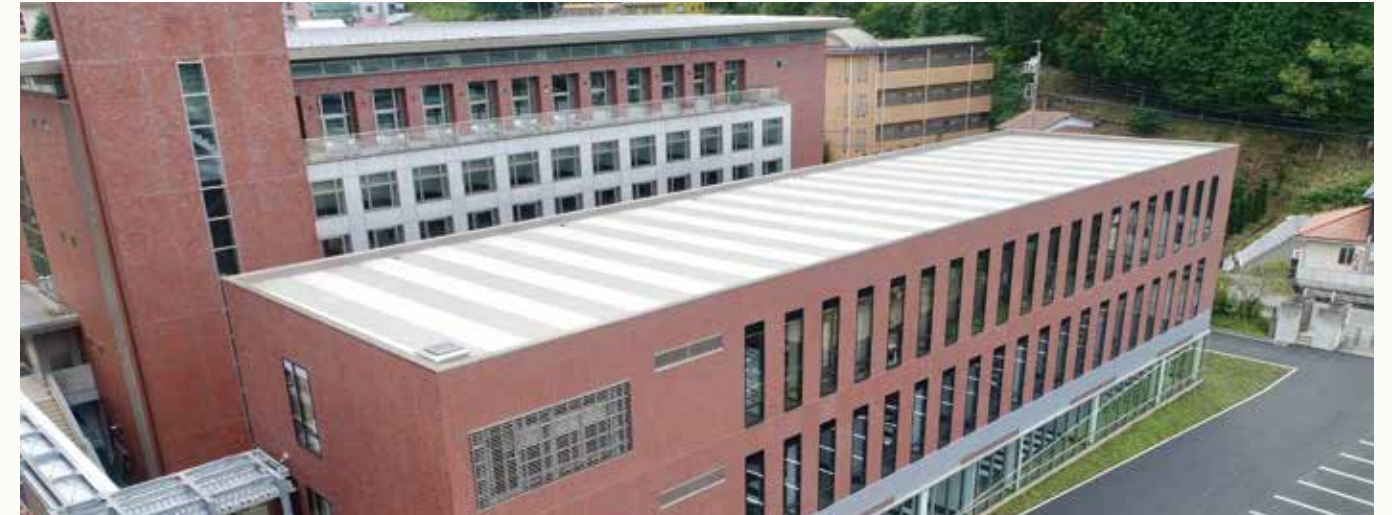
上武大学アリーナ 熱可塑性エラストマー系シート防水機械的固定断熱工法
