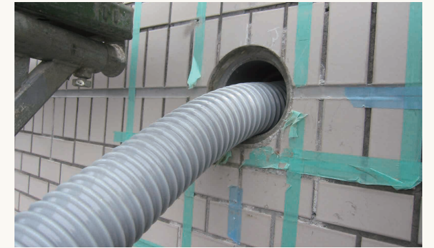
写真1 外壁のコア抜き
