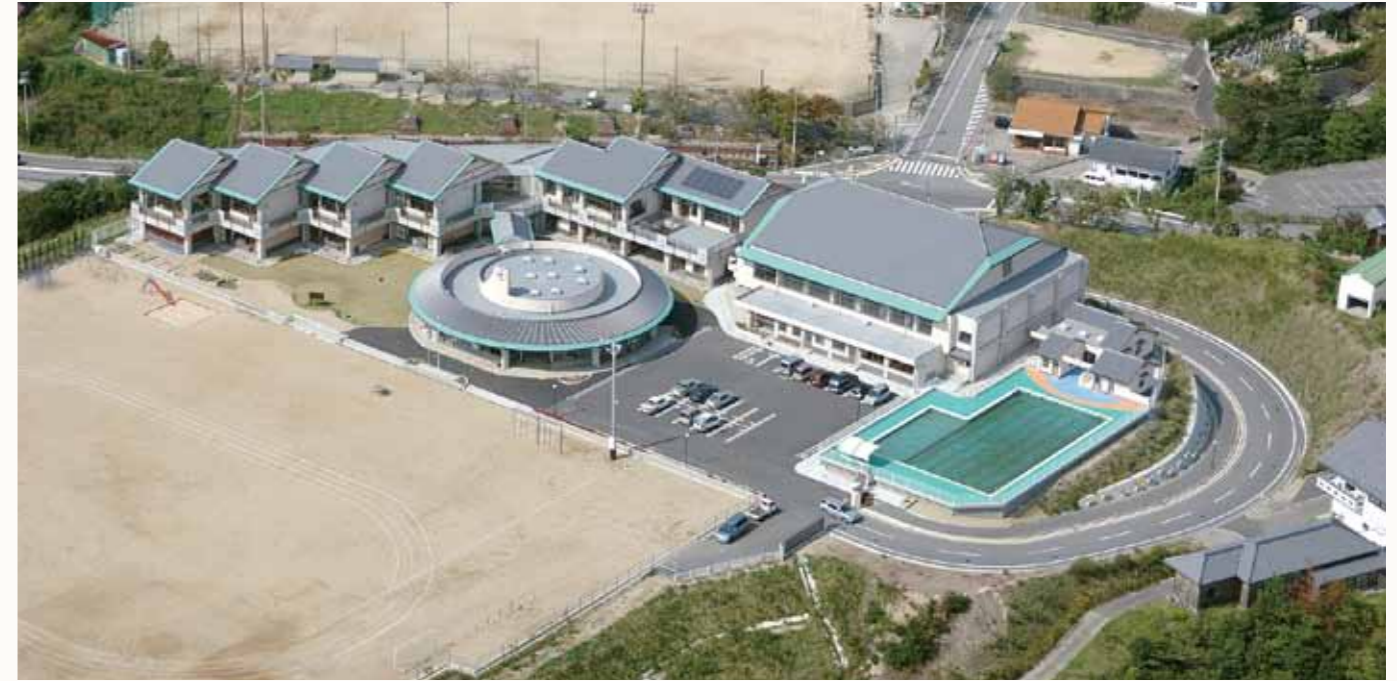
柏崎市文化会館アルフォーレ 塩化ビニル樹脂系シート防水機械的固定断熱工法
