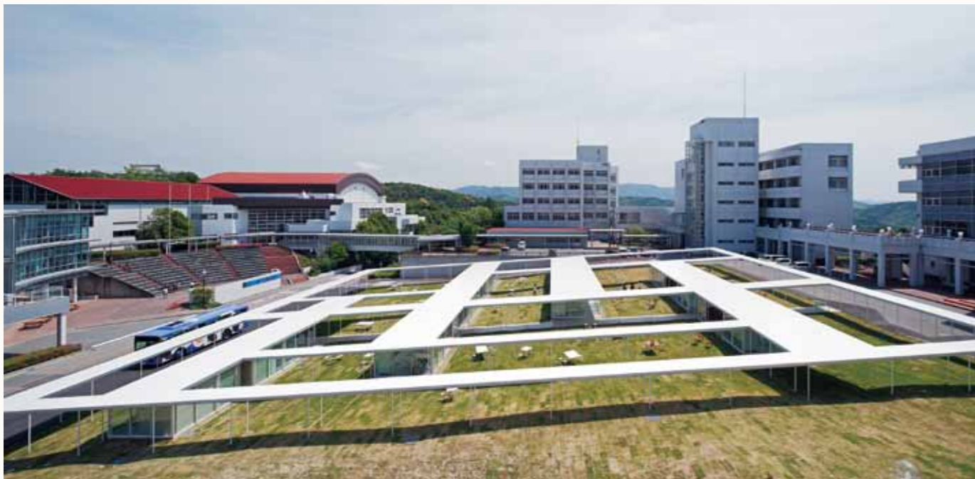
愛知産業大学 言語・情報共育センター 塩化ビニル樹脂系シート防水接着工法高反射率塗装仕上げ
