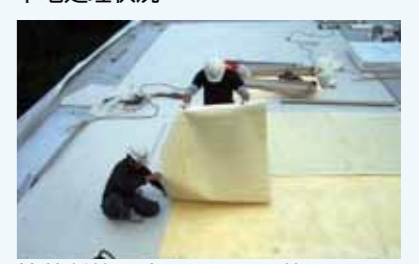
接着断熱工法シート張り状況
