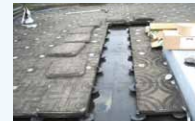
既設ルーフブロック非撤去部
