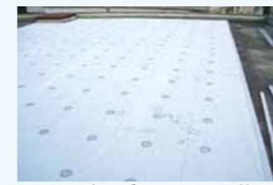
シート固定用ディスクの設置状況
