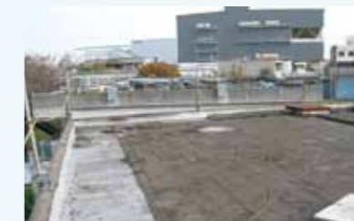
既設ルーフブロック撤去部
