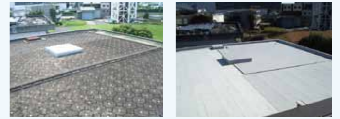
屋上の既設状況
