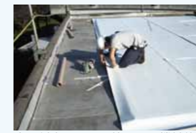
高反射率シートを使用した機械的固定断熱工法部
