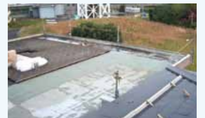
既設ルーフブロック撤去・接着工法下地処理状況
