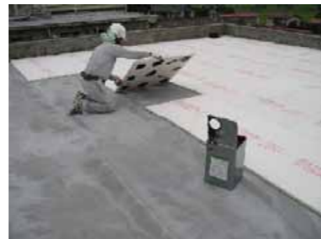
断熱材の接着施工状況
