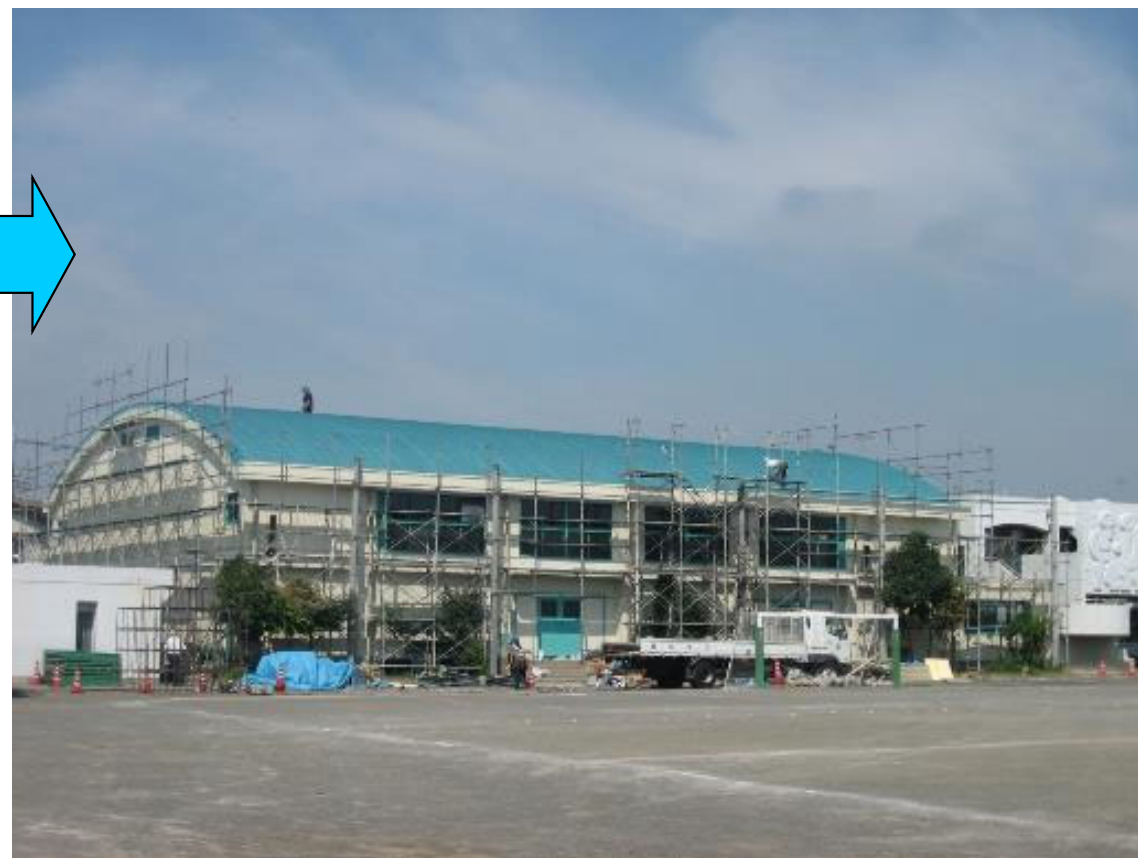
【施工後】 グリーン仕上げ
