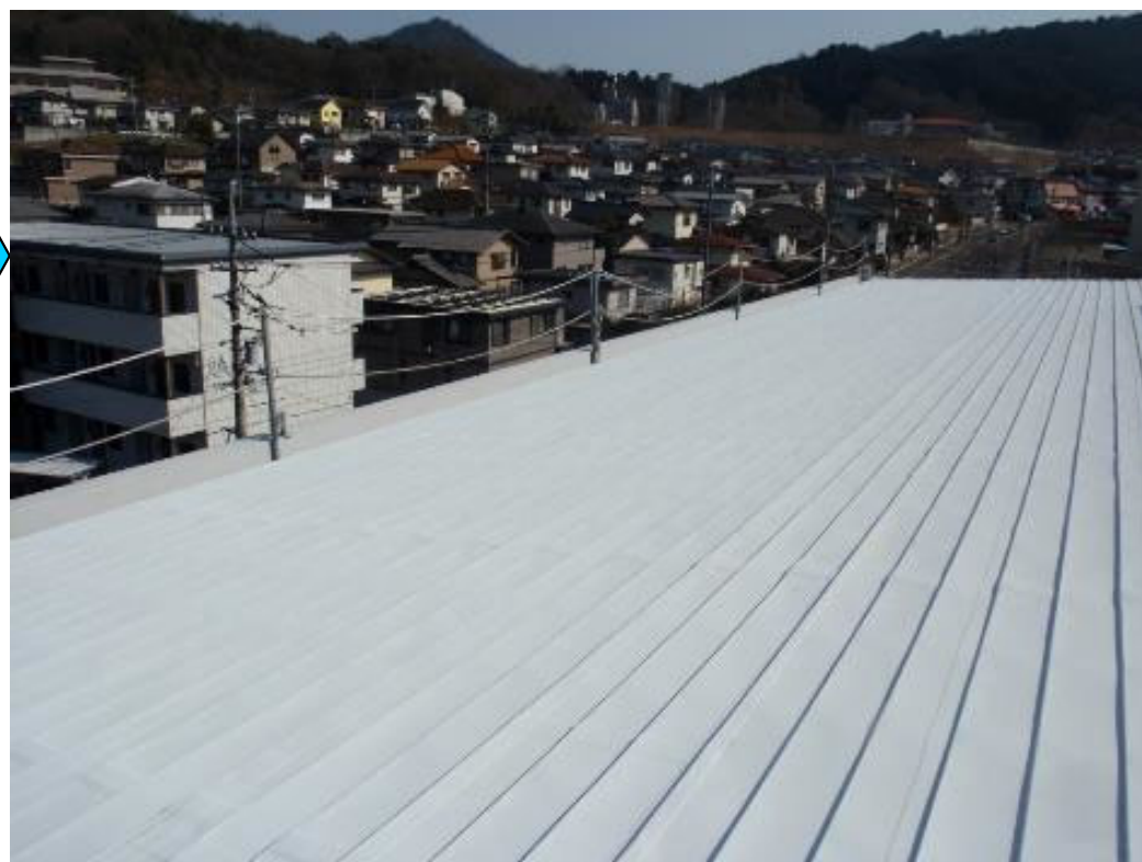
【施工後】 遮熱塗料仕上げ(ライトグレー)
