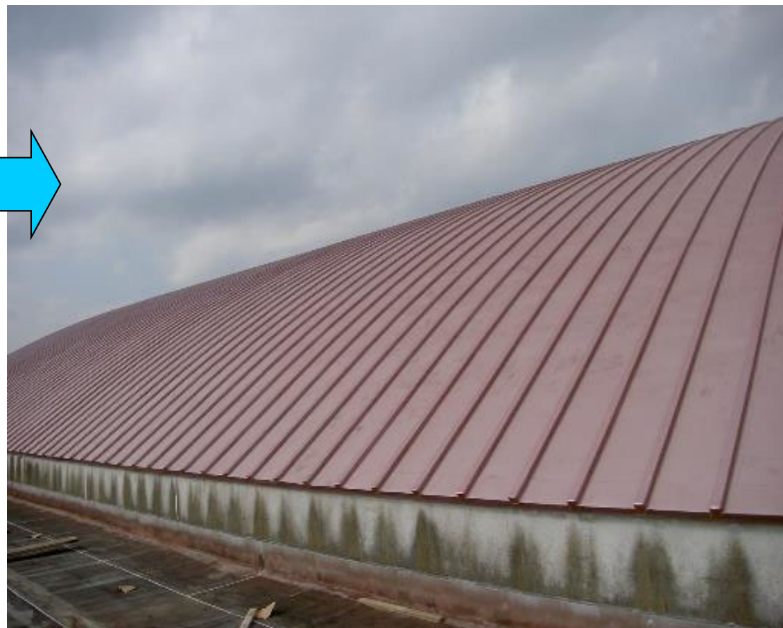
【施工後】 レッド仕上げ
