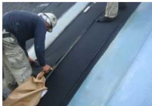
平場部のシート張付け
