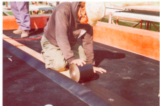
⑤ シート接合部の処理
