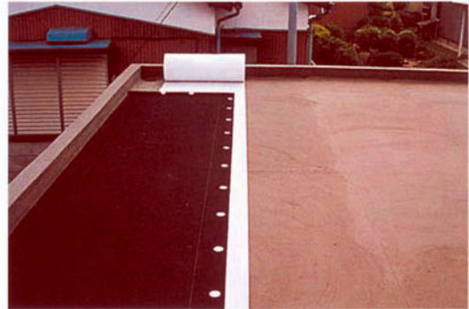
④ 固定金具による固定
