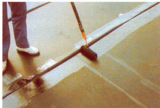
④シート接合部の処理
