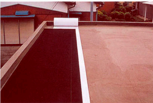
③ 加硫ゴムシートの敷設
