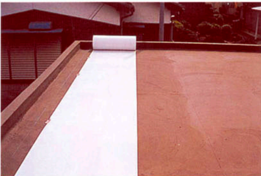
② 絶縁シートの敷設
