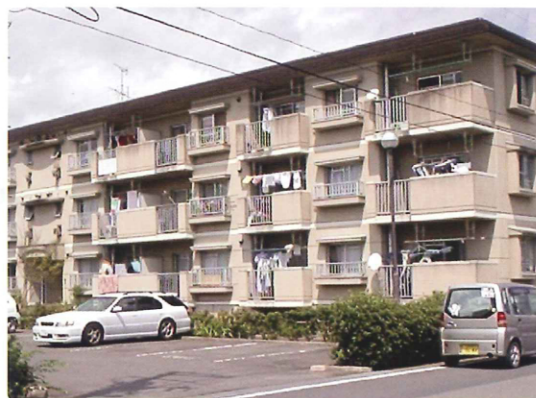
砂付アスファルト防水 改修事例 (町営団地 屋上)
