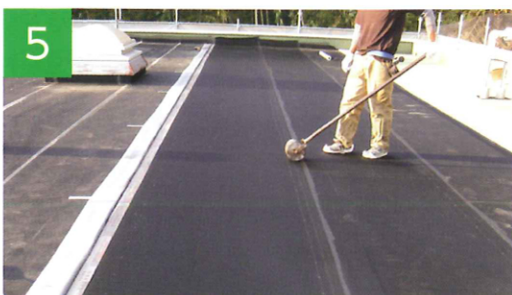
転圧ローラーによる張付け
