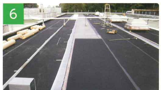
加硫ゴム系シートの接合処理
