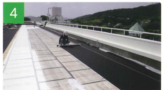
加硫ゴム系シートの敷設
