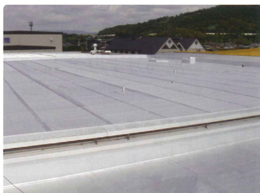
加硫ゴム系シート防水 改修事例 (工場 屋上)
