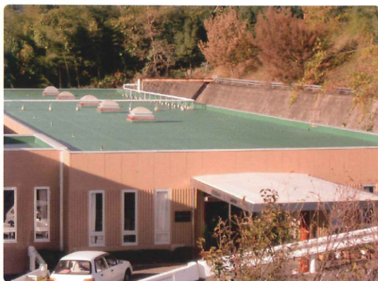
加硫ゴム系シート防水 改修事例 (老人ホーム 屋上)
