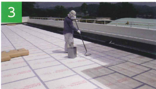
断熱材上への接着剤の塗布
