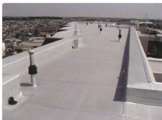
砂付アスファルト防水 改修事例 (民間マンション 屋上)
