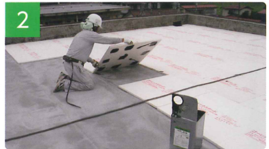
断熱材への接着剤塗布及び張付け・固定
