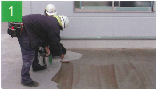
プライマーの塗布
