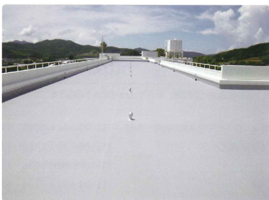
FRP系塗膜防水 改修事例 (小学校 屋上)
