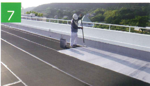
高日射反射率仕上塗料塗り
