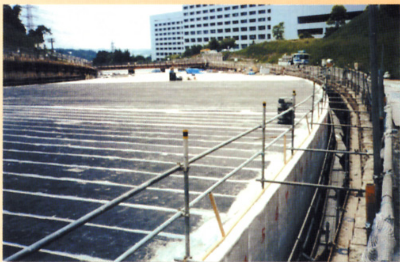
多摩丘陵モノレールトンネル部
